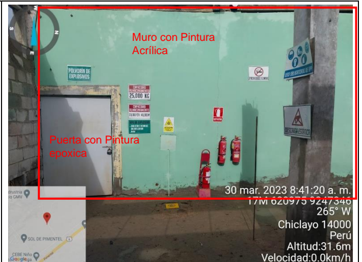
Polvorín colindante, igualmente se va realizar pintura a muro y puerta.
