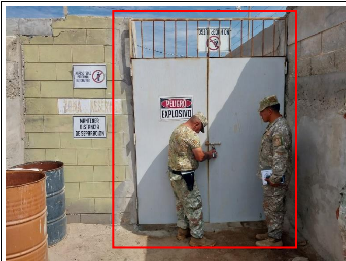
Puerta exterior (cerco), pintura epoxica.
