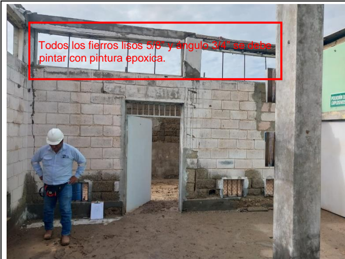
Pintura (Acrílica), en los muros y columna central
