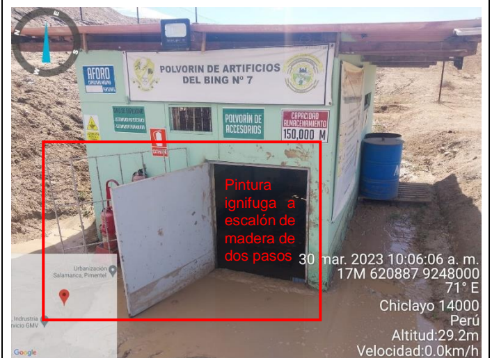
Puerta y protector (polvorín), pintura epoxica.
