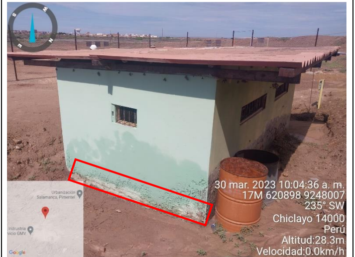
Tarrajeo exterior zonas puntuales de muros, pintura de muros exterior e interior, mantenimiento de ventanas.
