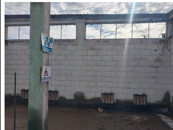
Tarrajeo intetior de muros y columna interior, reemplazo de ventanas, hacer piso semi pulido, cobertura de techo.
