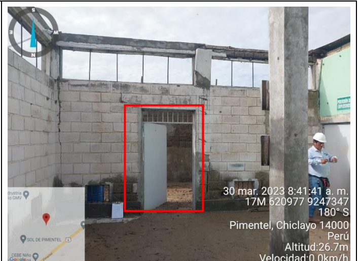
Puerta interior (polvorín), pintura epoxica.
