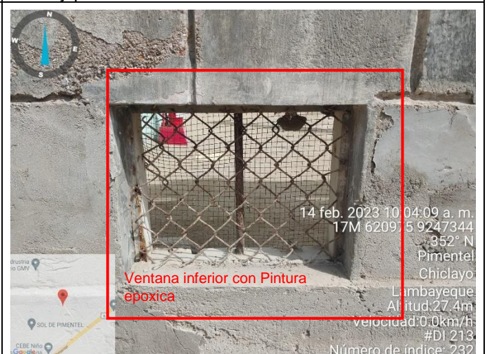
Reemplazo de ventanas inferiores incluir (malla olimpica y malla galvanizada).
